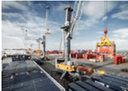
Dźwigi portowe i okrętowe
