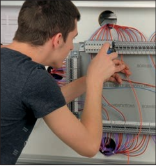
Panel tylny z zdjętą osłoną ochronną w celu wykonania okablowania.
