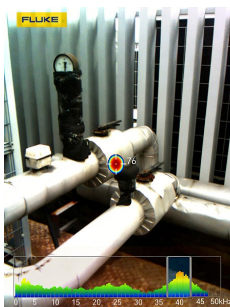
Wykrywanie wycieków w rurociągu
