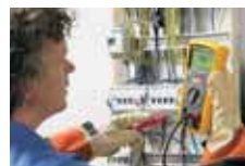
Test izolacji na panelu rozdzielczym
